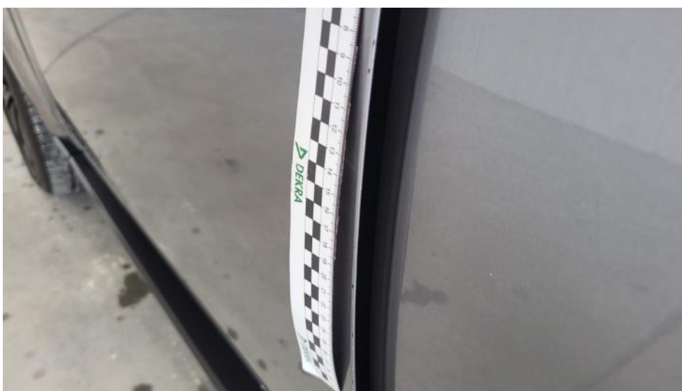
Fot. 72. Drzwi przed L - Rysa/odprysk 1
