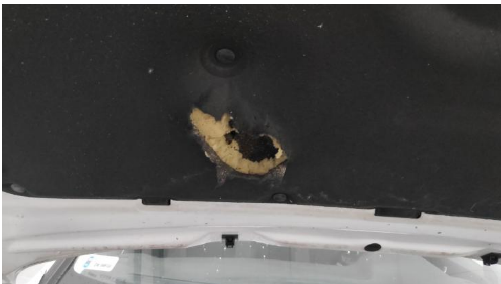
Fot. 43. Wykładzina pokrywy komory silnika - Pęknięcie/rozerwanie 1
