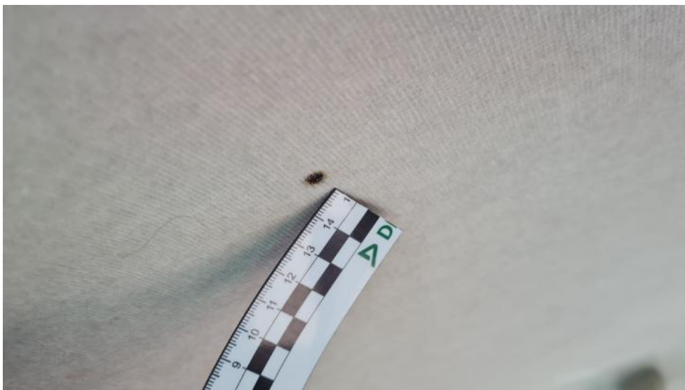
Fot. 65. Podsufitka - Inne 1
