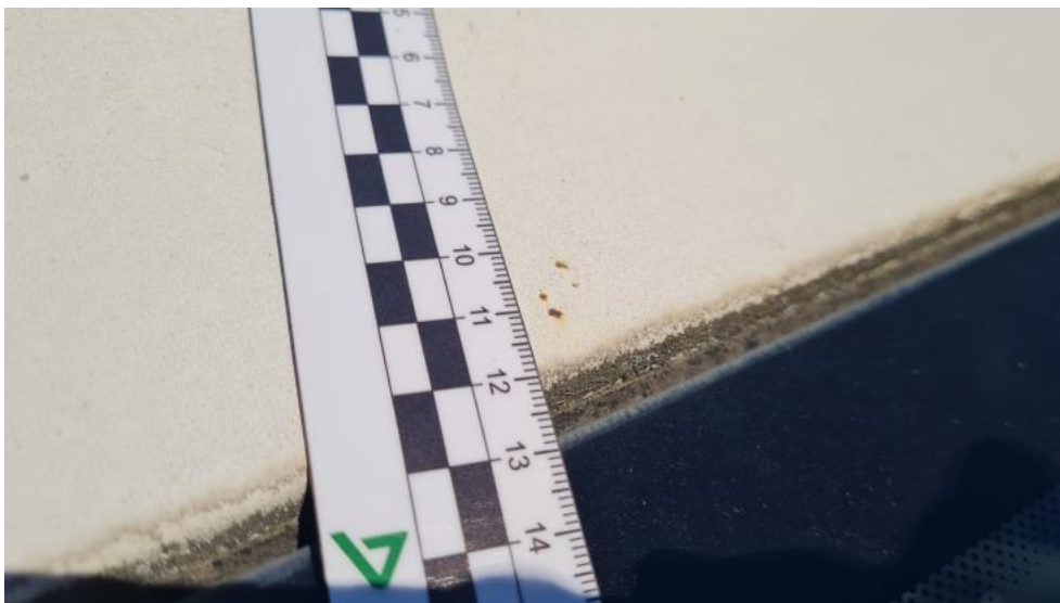
Fot. 55. Dach - Inne 1
