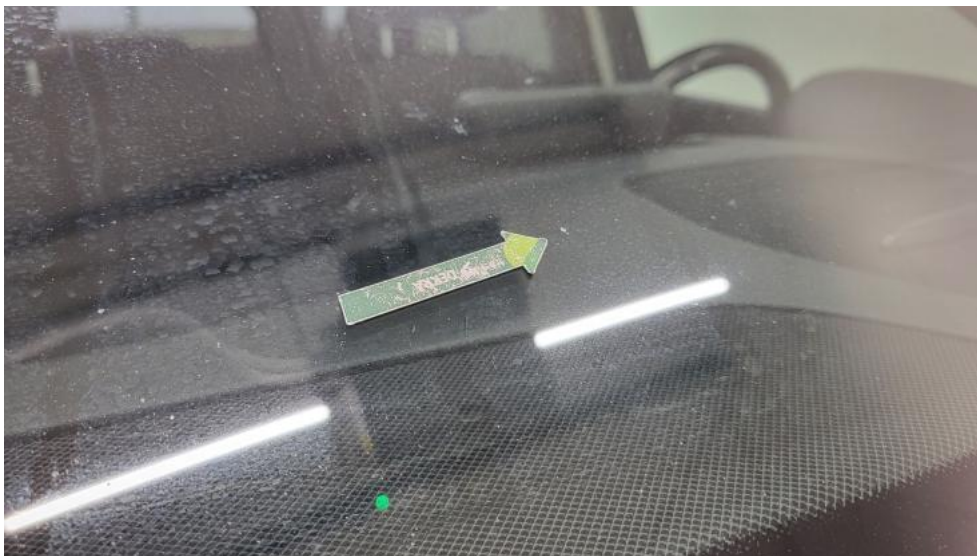
Fot. 49. Szyba czółowa() - Rysa/odprysk 3
