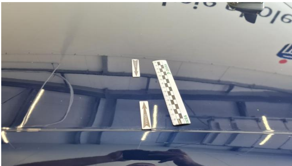
Fot. 51. Dach - zdjęcie poglądowe 2
