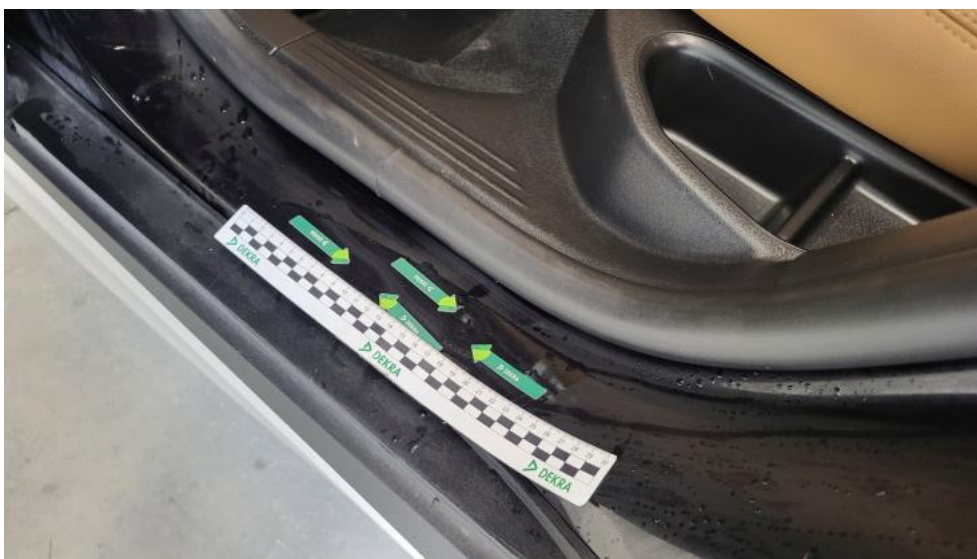
Fot. 59. Próg L - Wgniecenie/odkształcenie 1
