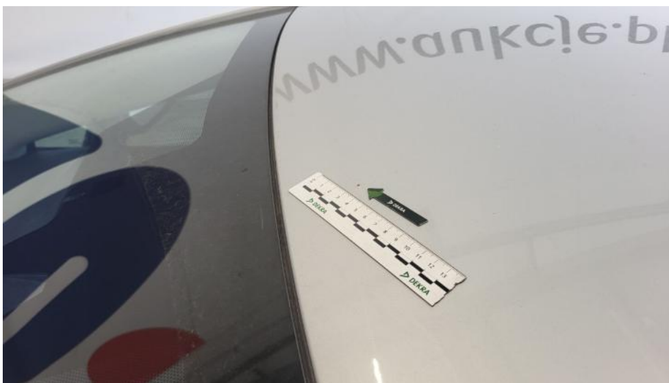
Photo 55. Dach - zdjęcie poglądowe 1
