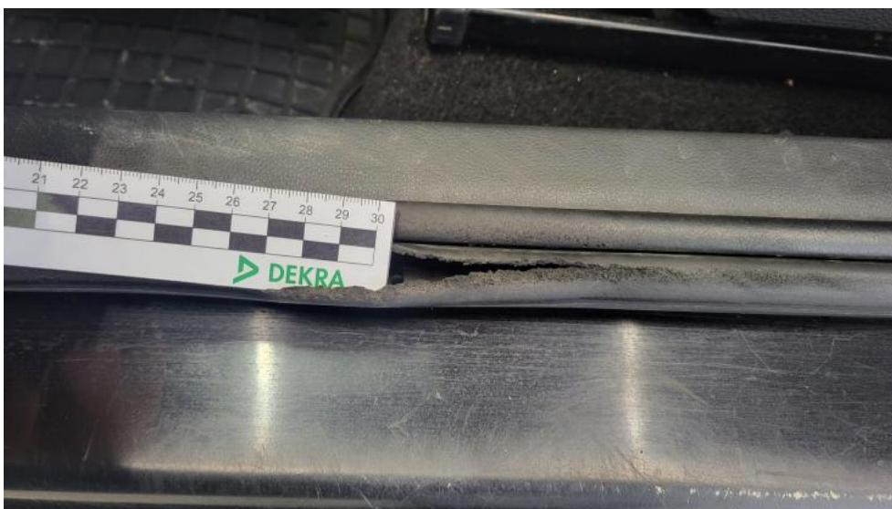
Fot. 190. Uszczelki progowe lew. - Pęknięcie/rozerwanie 1
