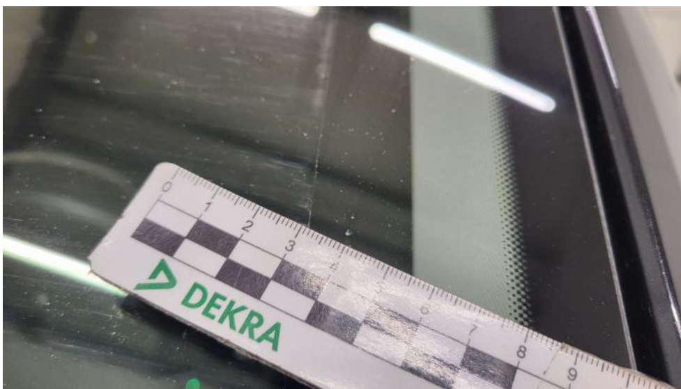
Fot. 39. Szyba czołowa - Rysa/odprysk 1
