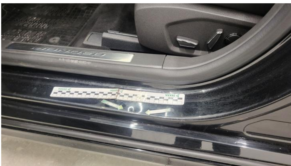
Fot. 60. Próg L - Wgniecenie/odkształcenie 1
