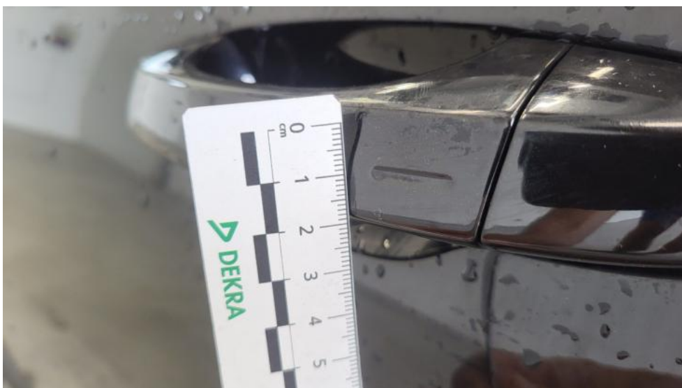
Fot. 60. Klamka drzwi prz L - Rysa/odprysk 1
