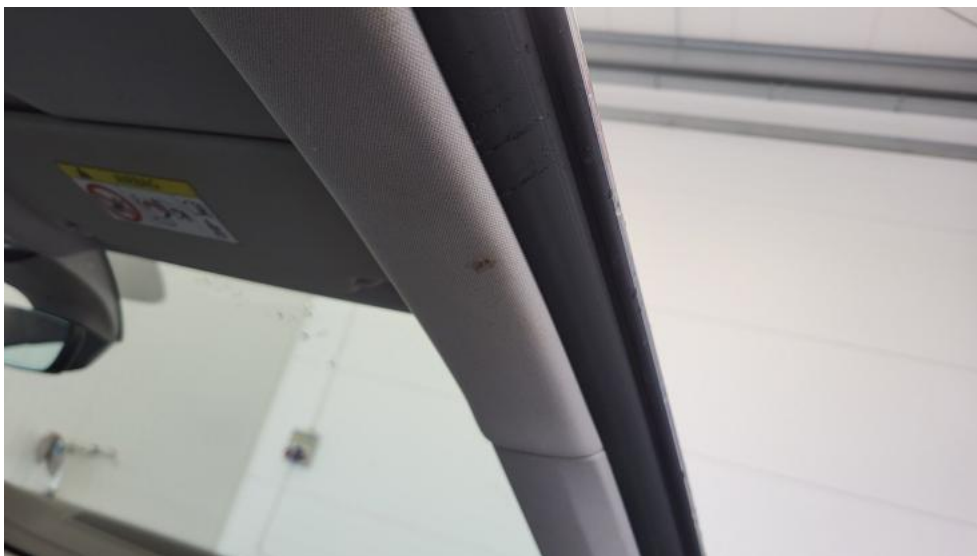
Fot. 69. Podsufitka - Inne 1
