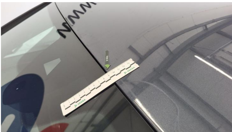
Fot. 60. Dach - zdjęcie poglądowe 1
