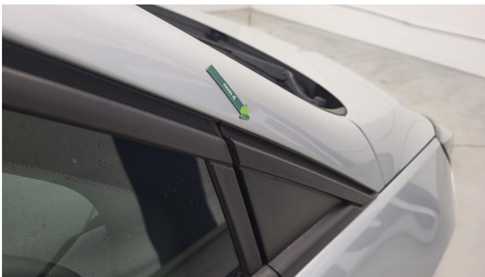
Fot. 50. Słupek przedni P - Wgniecenie/odkształcenie 1
