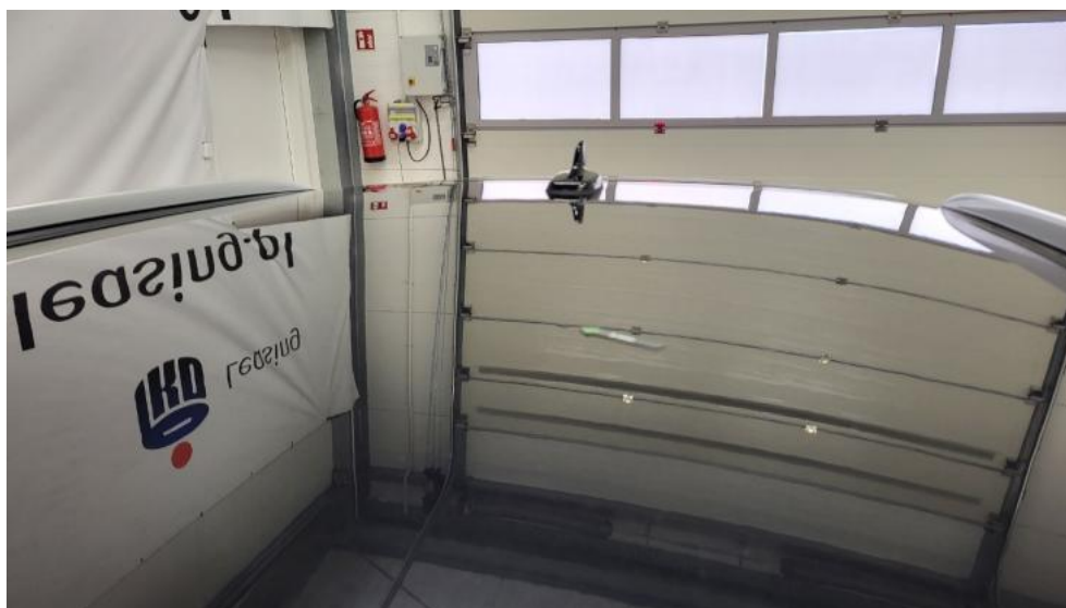
Fot. 73. Dach - Wgniecenie/odkształcenie 1
