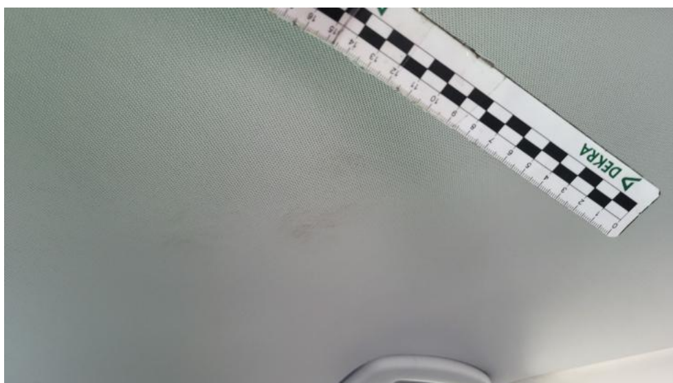
Fot. 96. Podsufitka - Inne 2
