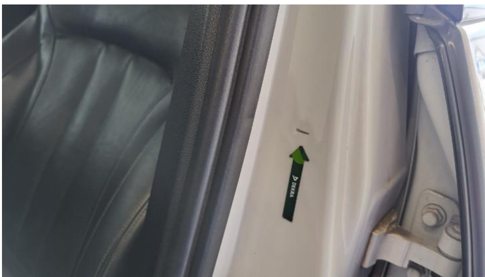
Photo 81. Stupek środkowy L - Wgniecenie/odkształcenie 1
