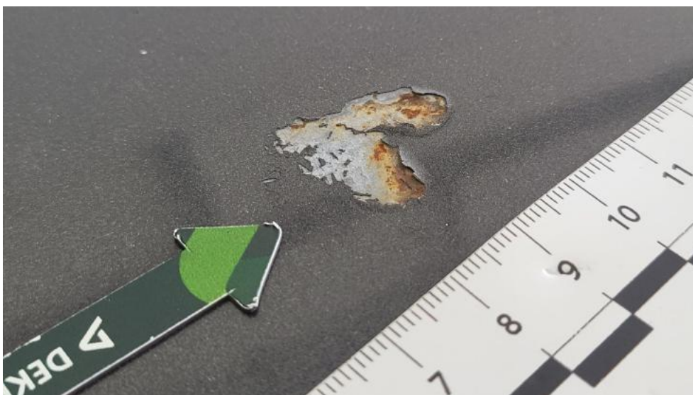
Fot. 74. Dach - Inne 1
