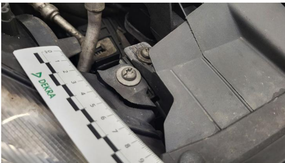
Photo 75. Reflektor P - Pęknięcie/rozerwanie 1
