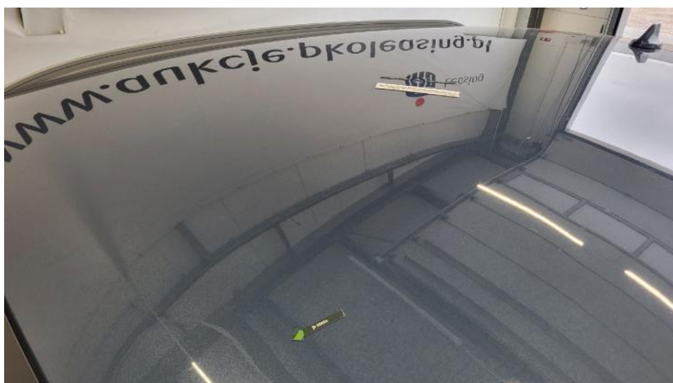
Fot. 46. Dach - Wgniecenie/odkształcenie 1
