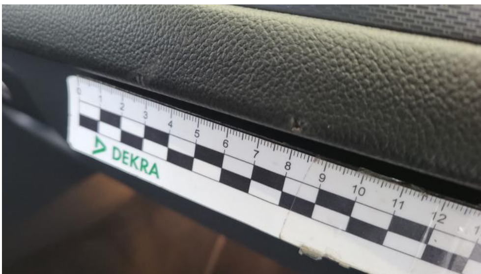
Fot. 92. Deska rozdzielcza - Pęknięcie/rozerwanie 1
