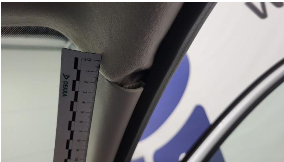
Fot. 71. Podsufitka - Inne 2
