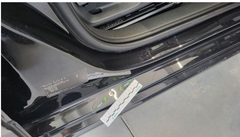
Photo 44. Próg P - Wgniecenie/odkształcenie 1
