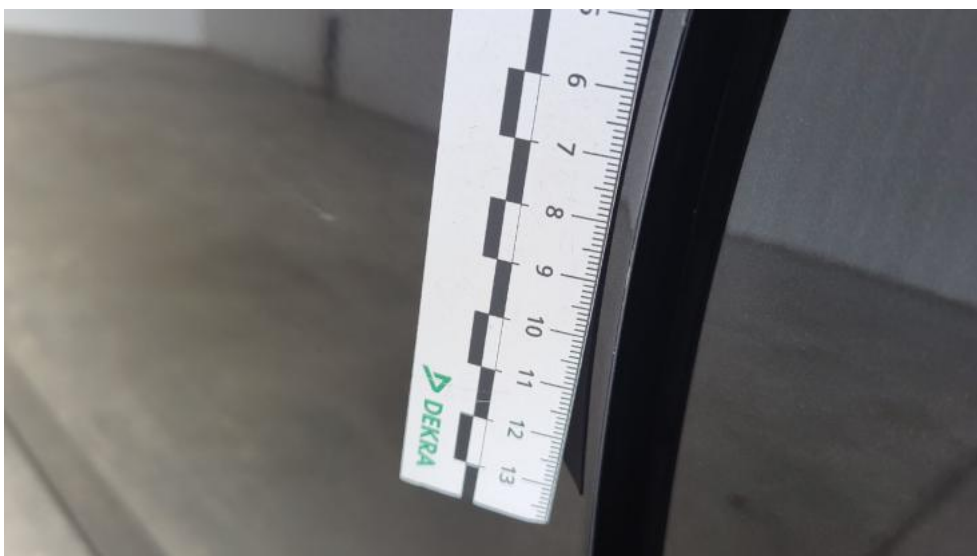
Photo 50. Drzwi przed L - Rysa/odprysk 1
