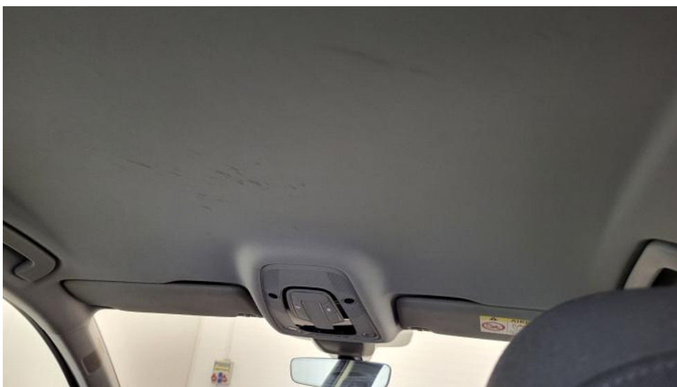
Fot. 93. Podsufitka - Inne 1
