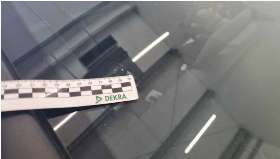
Fot. 37. Szyba czołowa - Rysa/odprysk 1
