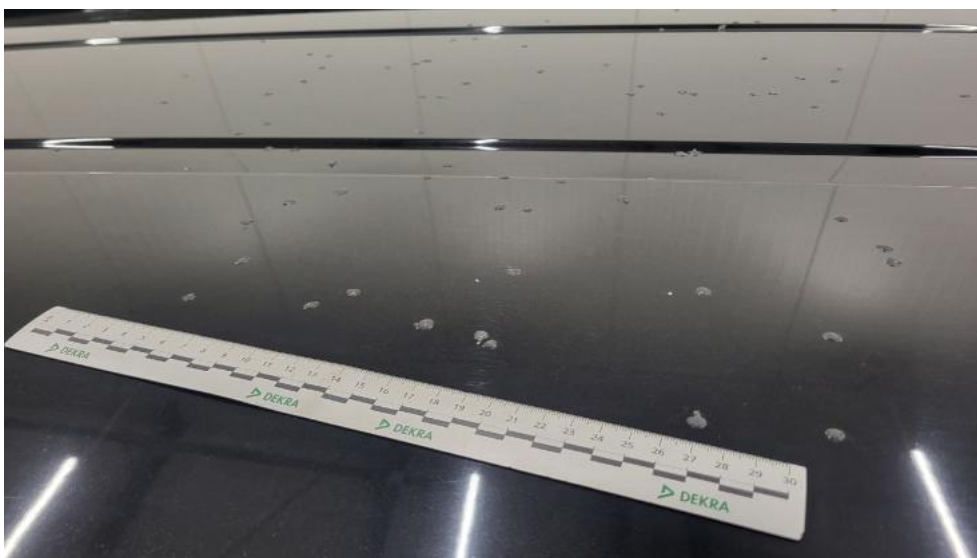
Fot. 50. Dach - Inne 1
