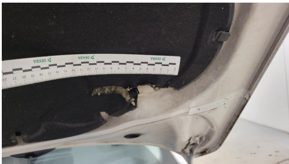
Fot. 42. Wykładzina pokrywy komory silnika - Pęknięcie/rozerwanie 1
