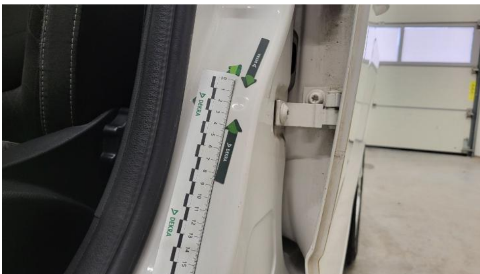
Fot. 72. Słupek środkowy L - Wgniecenie/odkształcenie 1
