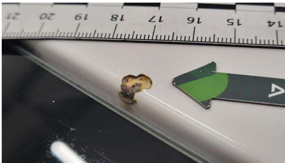
Fot. 63. Dach - Inne 1
