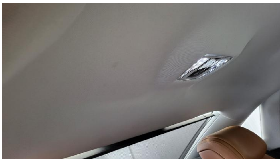
Fot. 74. Podsufitka - Inne 1
