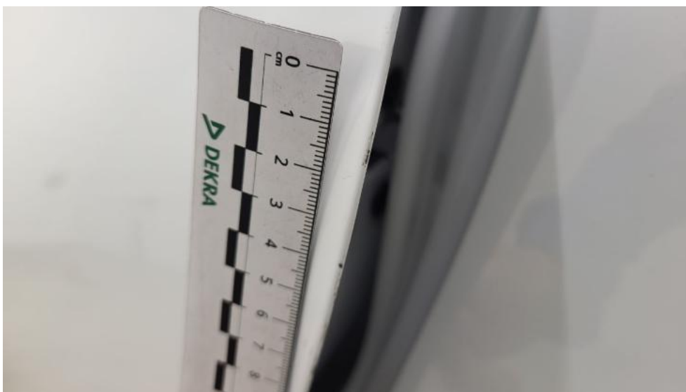
Photo 63. Drzwi tylne L - Rysa/odprysk 1
