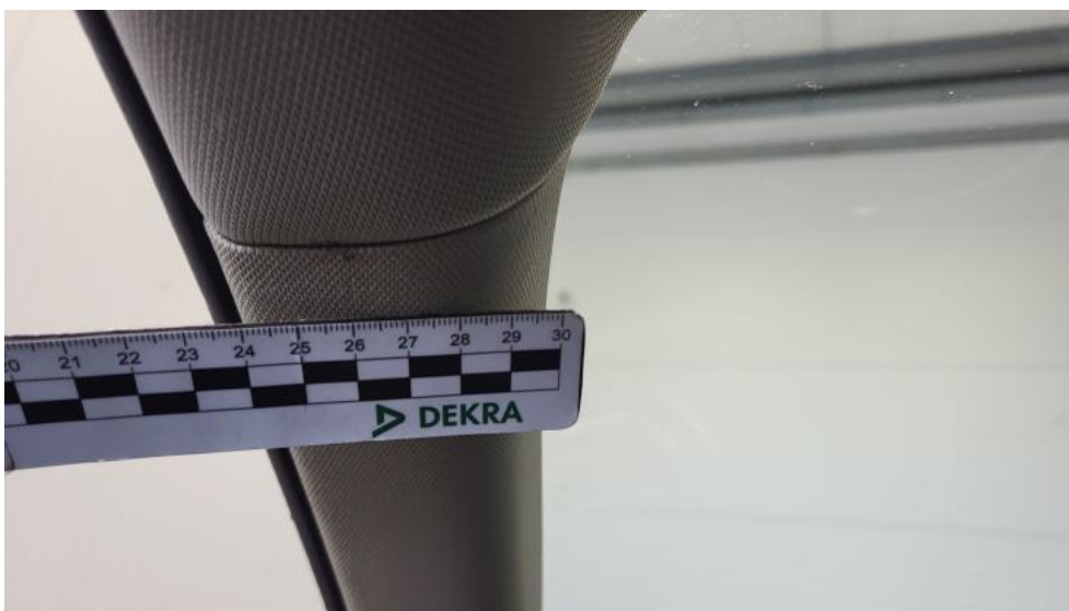
Fot. 61. Wykładzina(y) słupka przedniego L - zdjęcie poglądowe 1
