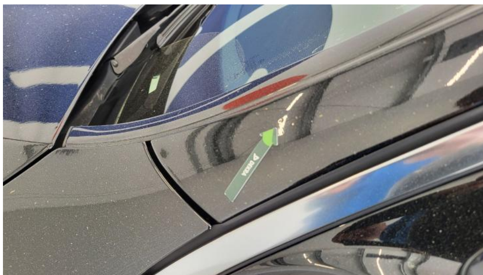
Fot. 58. Słupek przedni L - Wgniecenie/odkształcenie 1
