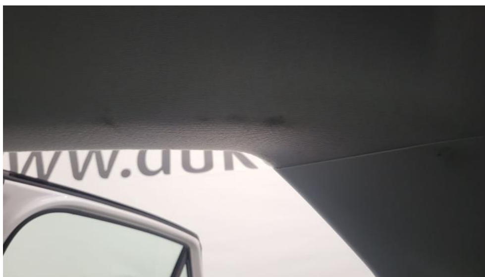
Fot. 72. Podsufitka - Inne 1
