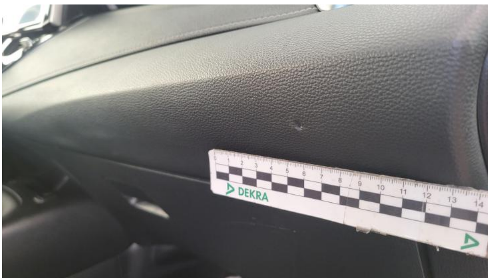
Fot. 106. Deska rozdzielcza - Wgniecenie/odkształcenie 1
