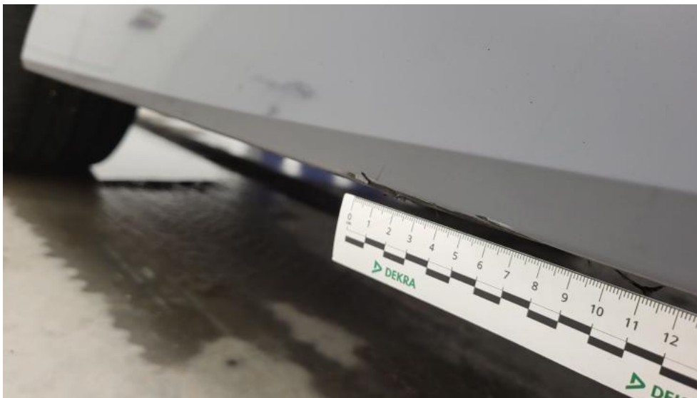
Photo 67. Próg L - Rysa/odprysk 1
