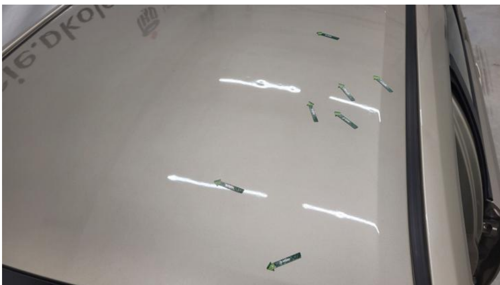
Photo 67. Dach - zdjęcie poglądowe 1
