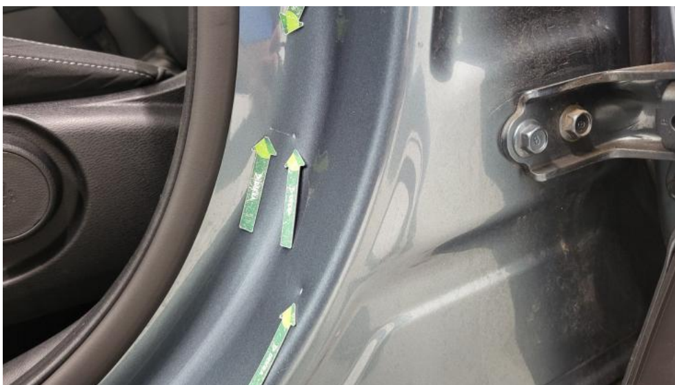
Photo 69. Słupek środkowy L - Wgniecenie/odkształcenie 1
