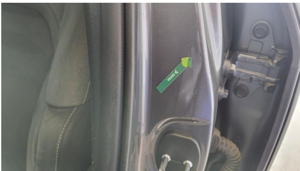
Photo 80. Słupek środkowy L - Wgniecenie/odkształcenie 1
