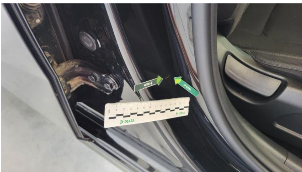
Fot. 64. Słupek środkowy P - Wgniecenie/odkształcenie 1
