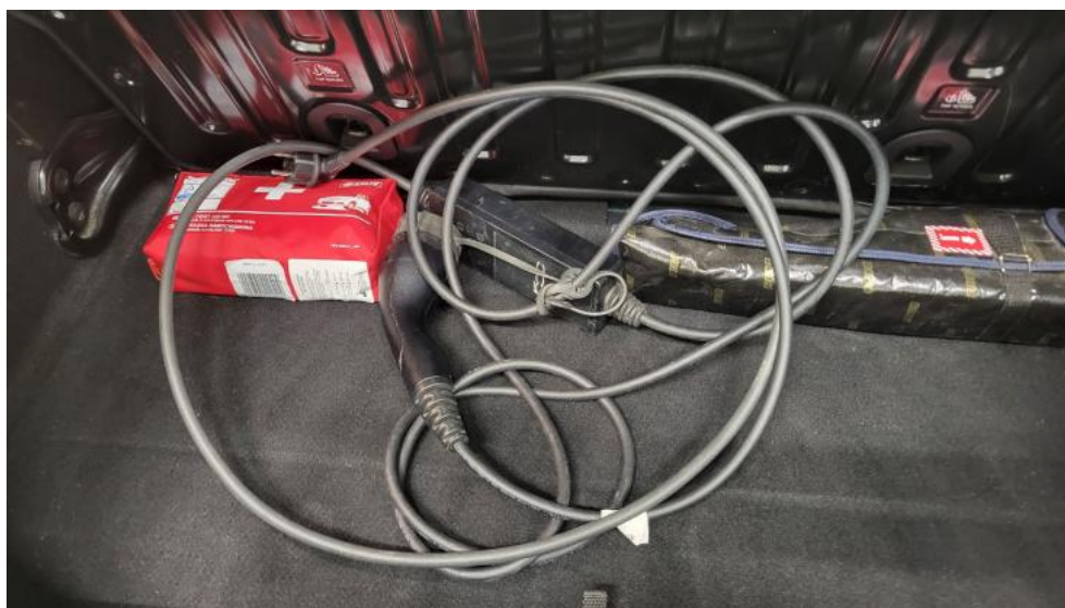
Fot. 35. Przewód ładowania baterii trakcyjnej
