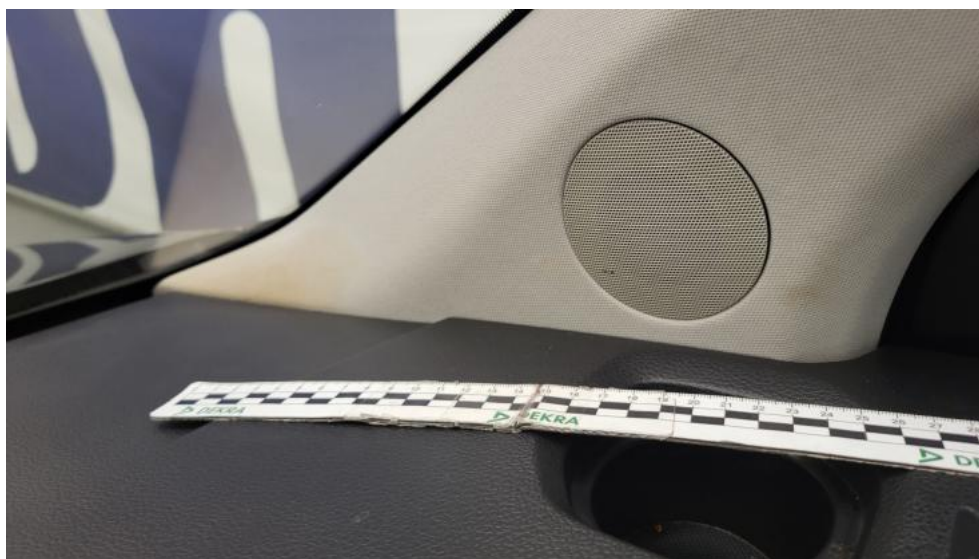
Fot. 91. Wykładzina(y) słupka przedniego P - Inne 1
