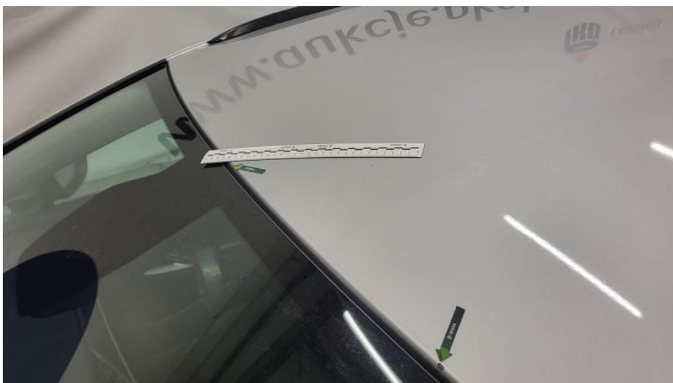
Fot. 54. Dach - zdjęcie poglądowe 1
