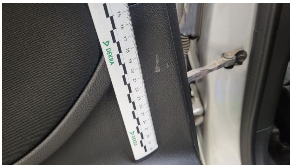
Fot. 75. Tapicerka drzwi tylnych L - Rysa/odprysk 1
