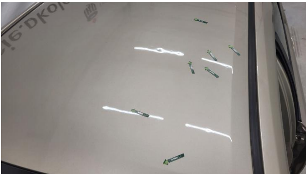
Fot. 67. Dach - zdjęcie poglądowe 1
