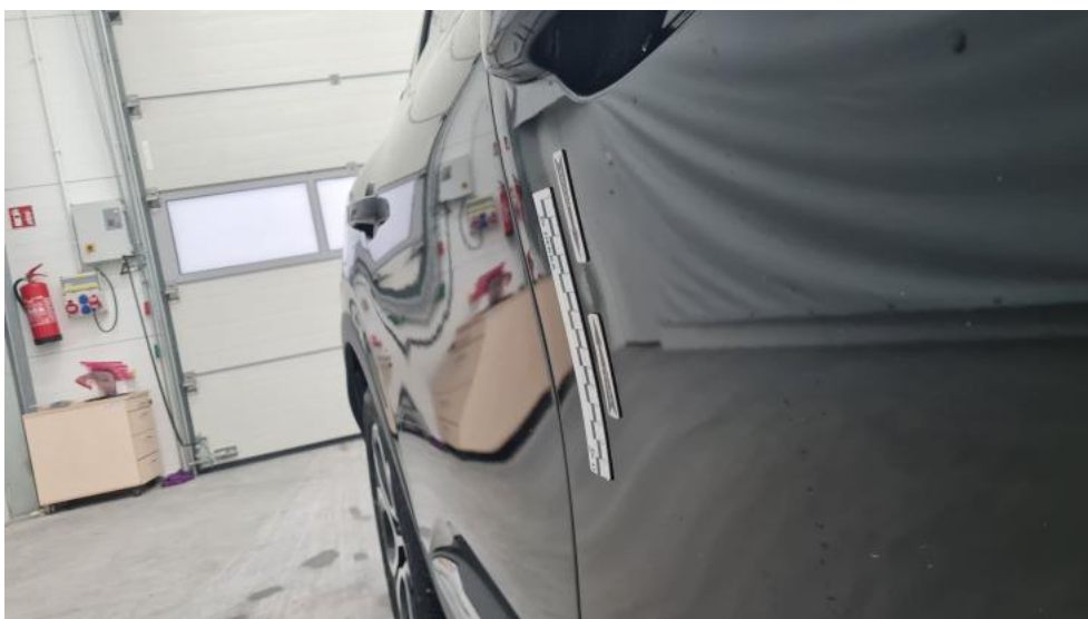
Fot. 48. Drzwi przednie P - Wgniecenie/odkształcenie 1
