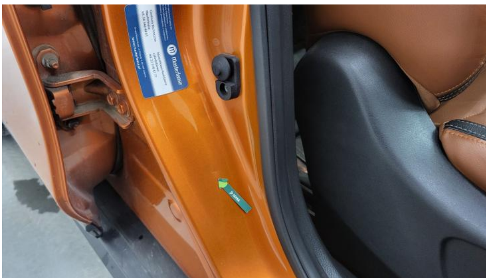
Fot. 73. Stupek środkowy P - Wgniecenie/odkształcenie 1
