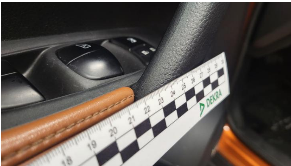
Fot. 123. Uchwyt drzwi prze L - Rysa/odprysk 1
