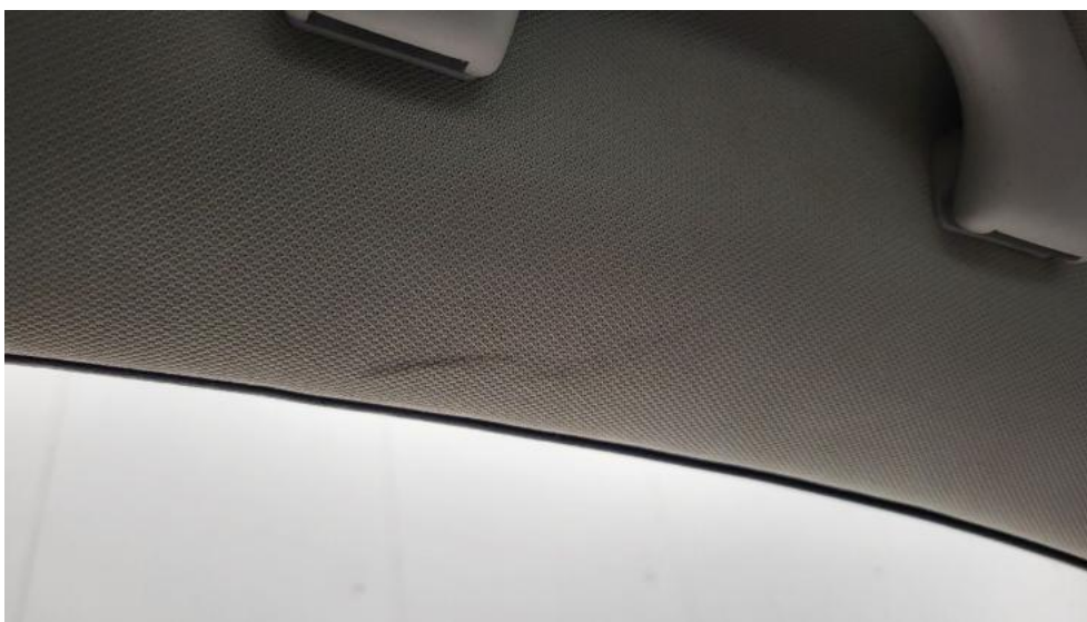
Fot. 85. Podsufitka - Inne 1
