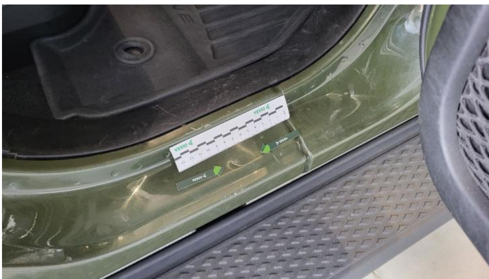
Photo 50. Próg P - Wgniecenie/odkształcenie 1
