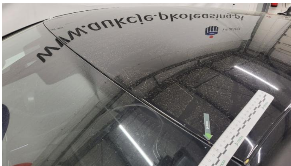
Photo 70. Dach - zdjęcie poglądowe 1
