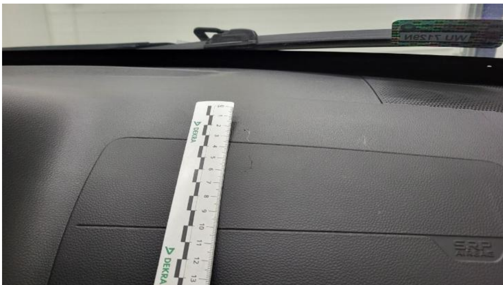
Fot. 74. Deska rozdzielcza - Rysa/odprysk 1
