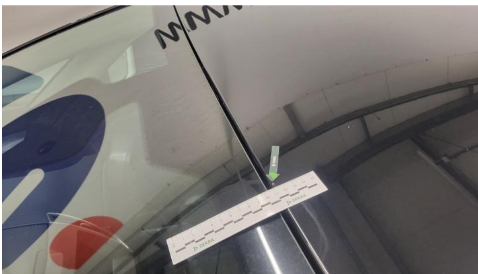
Photo 74. Dach - zdjęcie poglądowe 1
