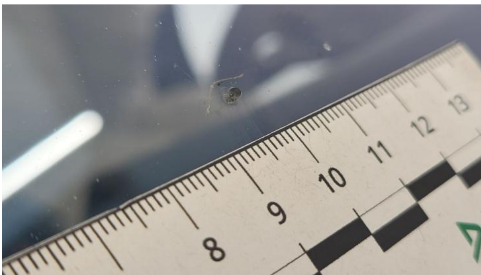
Fot. 57. Szyba czołowa - Pęknięcie/rozerwanie 1
