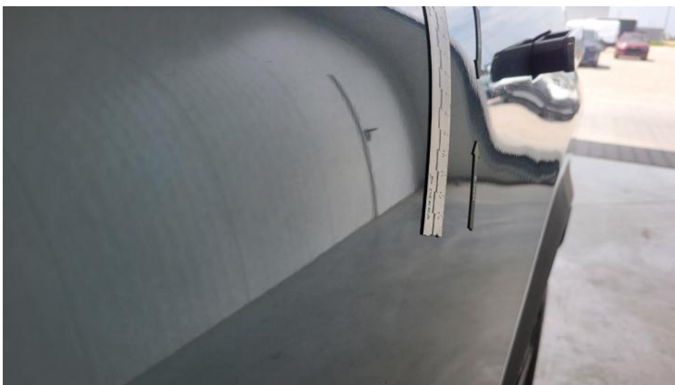
Fot. 64. Drzwi tylne L - Wgniecenie/odkształcenie 1
